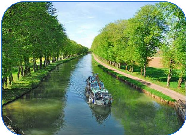
Le canal a été construit au gabarit défini par l'Ingénieur Freycinet, pour des péniches d'une longueur de 38,50m, d'une largeur de 5,05 m, d'un tirant d'eau de 2,00 m, et pouvant transporter 310 tonnes de fret.
