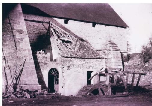
Les restes du haut-fourneau de la Thuillière au début du XX<sup>ème</sup> s. avant son démantèlement. En 1818, il produisait 500 tonnes de fontes, consommait 2000 tonnes de minerais et 700 tonnes de charbon de bois. Actuellement seule la halle à charbon, les logements ouvriers, quelques ouvrages hydrauliques et l'emplacement de l'étang en amont sont encore visibles. La "crasse", résidu de la combustion du haut-fourneau se ramasse autour du bâtiment et sur les chemins alentours.
