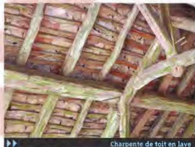
Charpente de toit en lave
