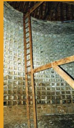
axe vertical. Aux extrémités de cet axe, deux pivots permettent à l'échelle simple, double, droite ou inclinée, de tourner.
