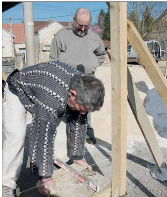
La pose de la première pierre du four à pain, sous l'œil de Guy Jannaud.
