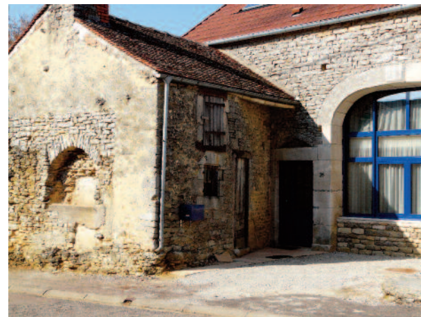
La chambre à four
