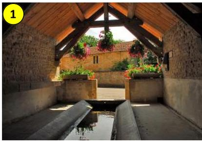
La toiture supportée par de solides pièces de charpente posées sur des corbeaux de pierre et les murs ouverts uniquement du côté de la rue, permettaient aux lavandières de travailler à l'abri du soleil, des intempéries et des courants d'air, lors des grandes lessives ou « buées ».
